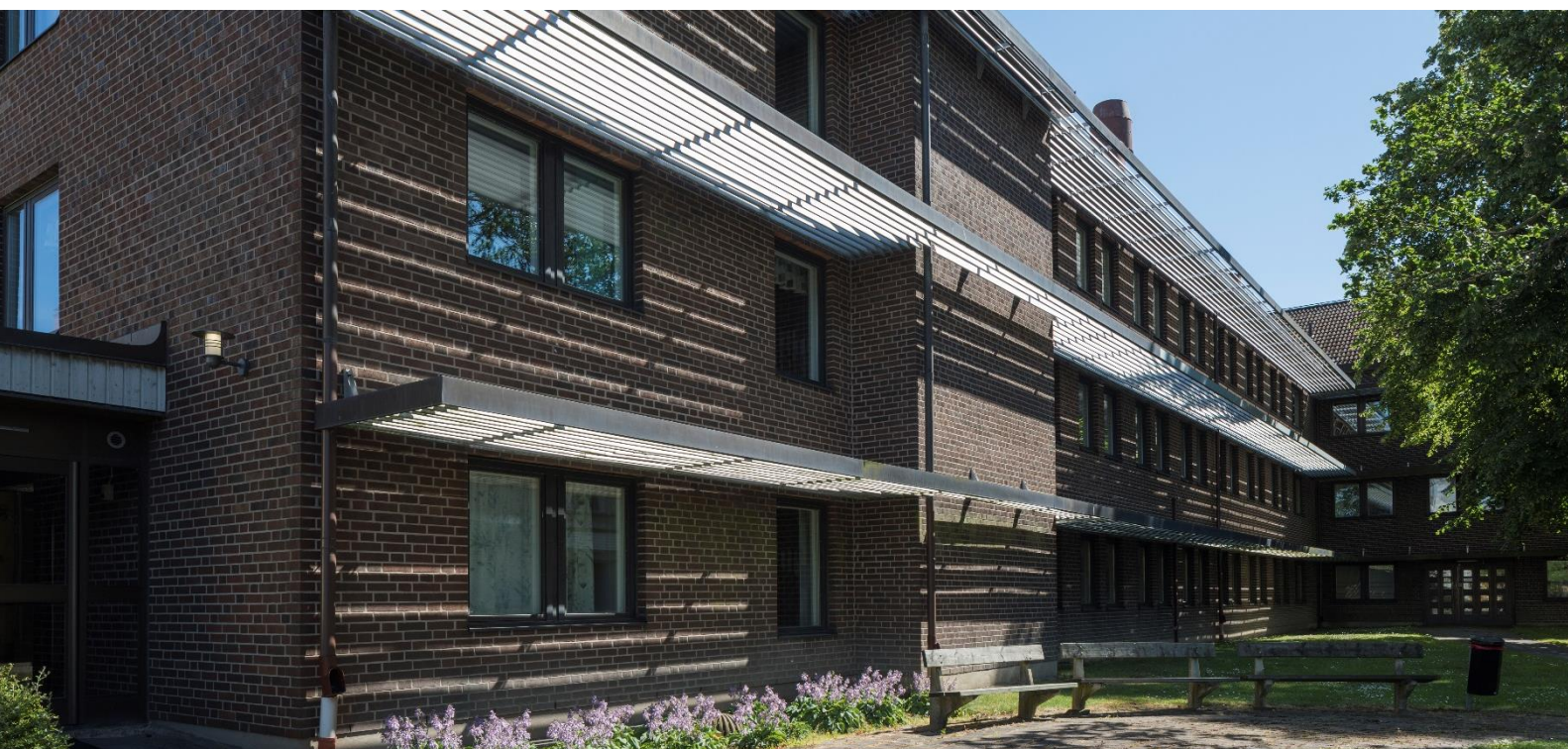
Exterior of the property Klöver 7, Vänersborg.
