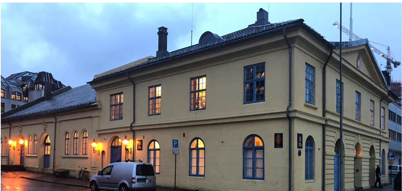
Exteriörbild från fastigheten Vestre Strandgate 21 där Tullmyndigheten i Kristiansand är hyresgäst.
