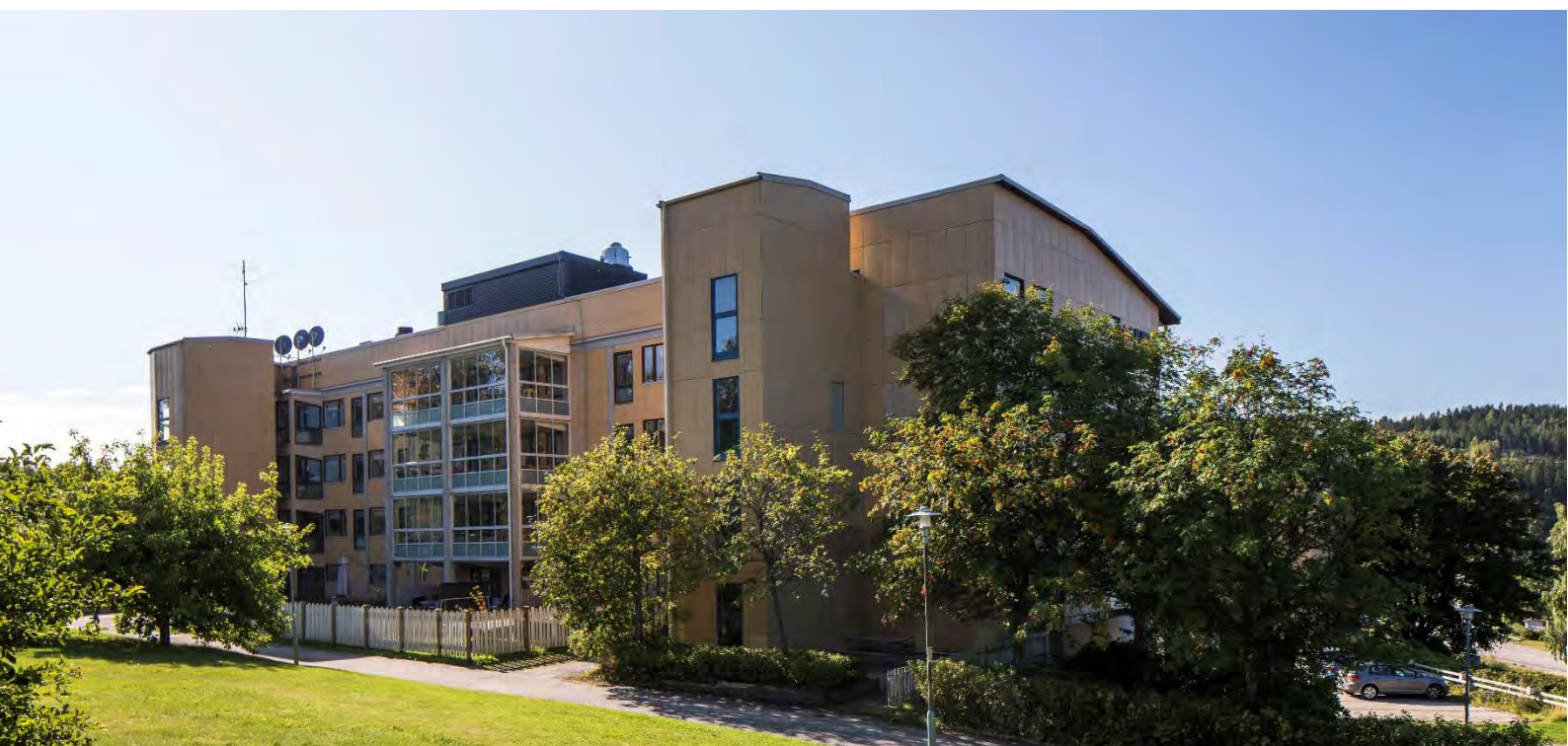
Exteriörbild från fastigheten Härsta 9:5, Sundsvall.
